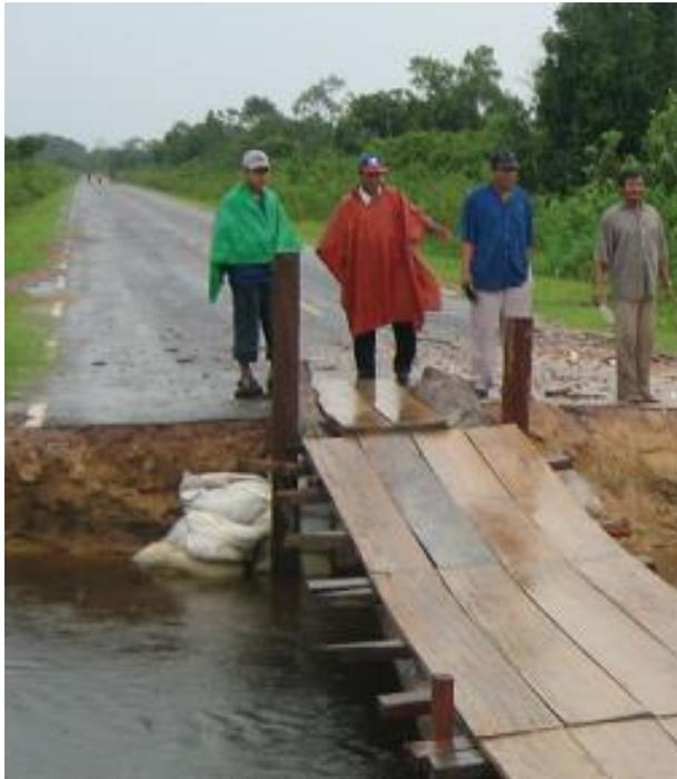
Figura 5. Daño carretero por afectación del huracán Stan. Imagen de internet.
